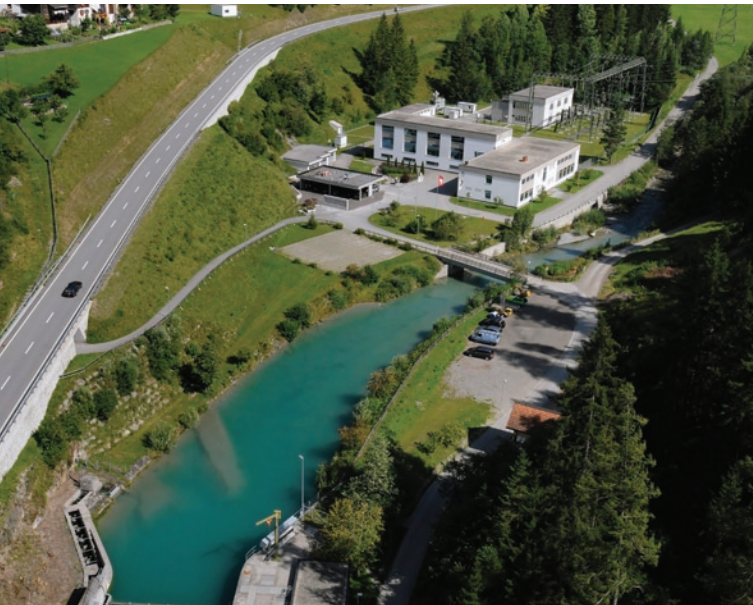
Fotos: Albula-Landwasser Kraftwerke AG
